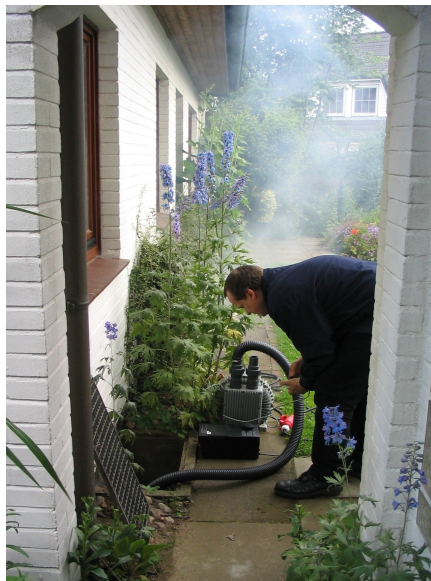
Nebelversuch an einem Abwasserrohr
